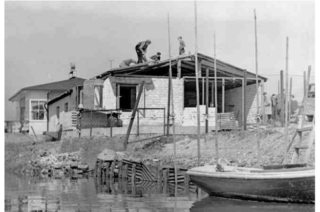
Das Bootshaus entsteht
