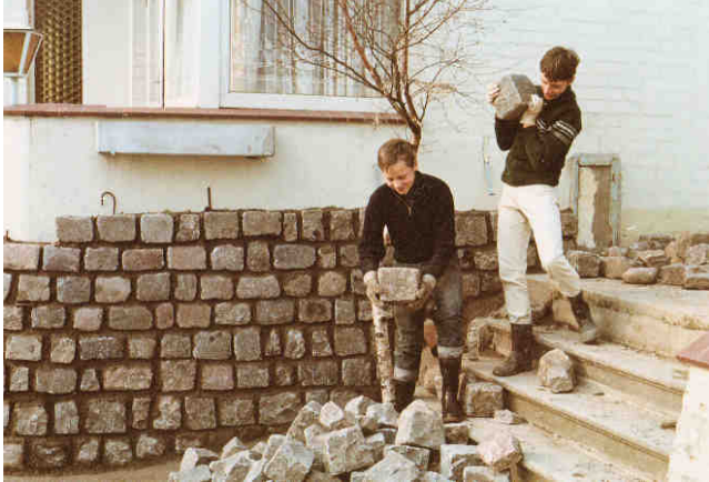
Bau der vorgesetzten Natursteinmauer
