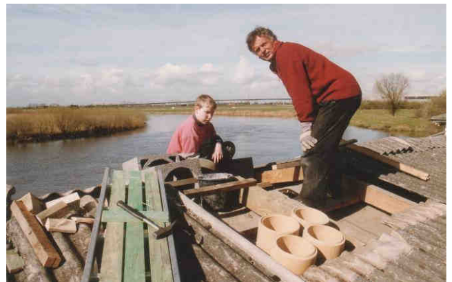
Frühjahrsarbeitsdienst: Bau des Schornsteins
