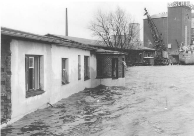
Das Bootshaus ist schwer beschädigt
