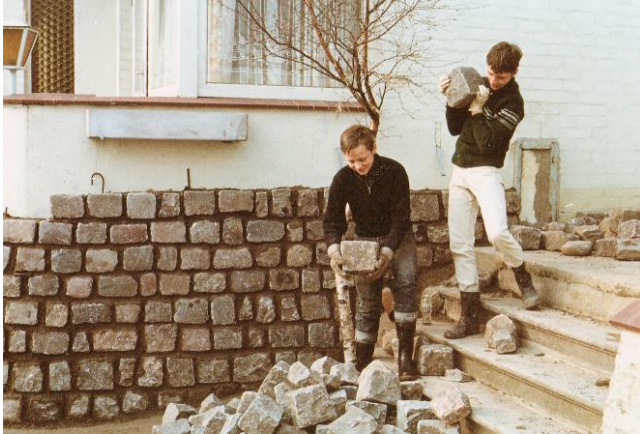
Bau der vorgesetzten Natursteinmauer
