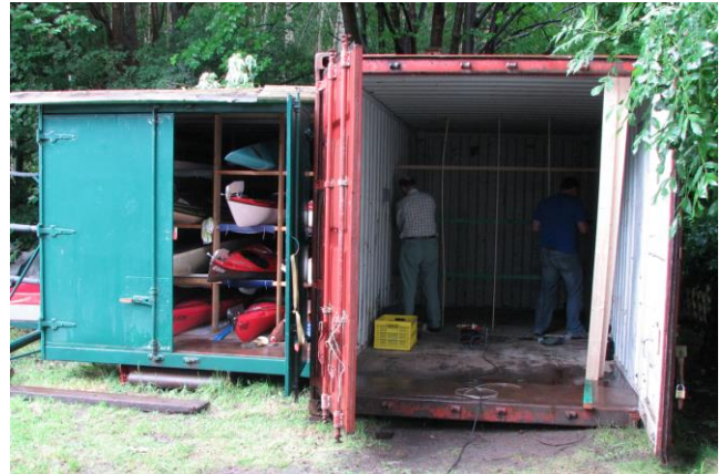
Der Bootsagercontainer wird ausgebaut
