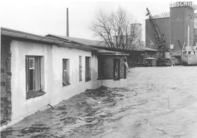
Das Bootshaus ist schwer beschädigt
