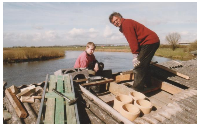
Frühjahrsarbeitsdienst: Bau des Schornsteins
