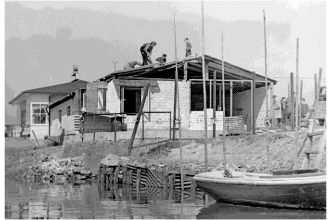
Das Bootshaus entsteht
